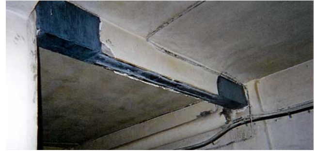
Figura 3. Refuerzo completo de una viga de un aparcamiento. Se aprecia la fibra aplicada como refuerzo de cortantes y el laminado para soportar las tracciones.
