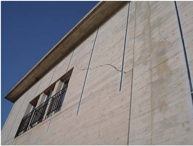
Figura 1. Refuerzo con laminado para cumplir requerimientos sísmicos. CH Zorita. Unión FENOSA.
