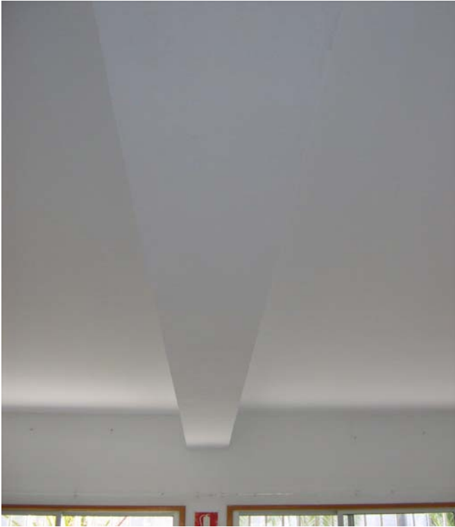
Fig. 9. Trabajo finalizado de refuerzo a flexión y a cortante en vigas.
