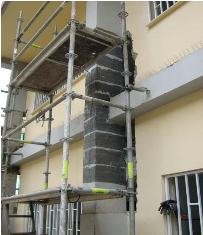
Fig. 13. Refuerzo de pilar a compresión.
