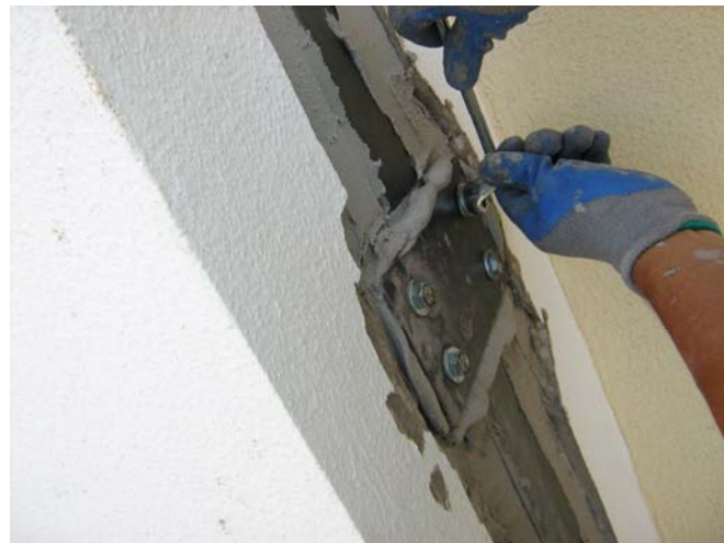
Fig. 23. Refuerzo pilar a tracción y anclaje con chapa metálica de lamina de carbono.
