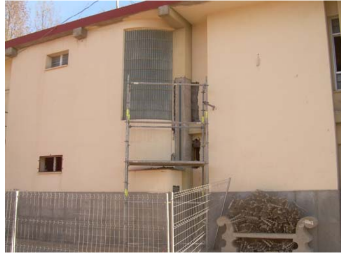
Fig. 11. Refuerzo a tracción de pilar.
