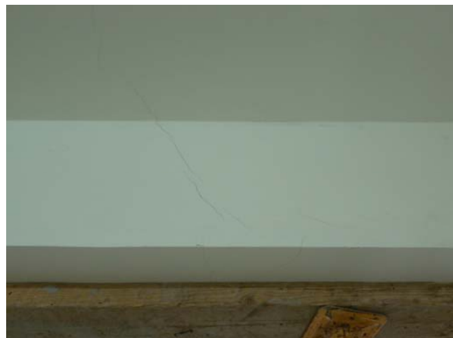
Fig. 2. Frontal viga biblioteca. Módulo 1.
