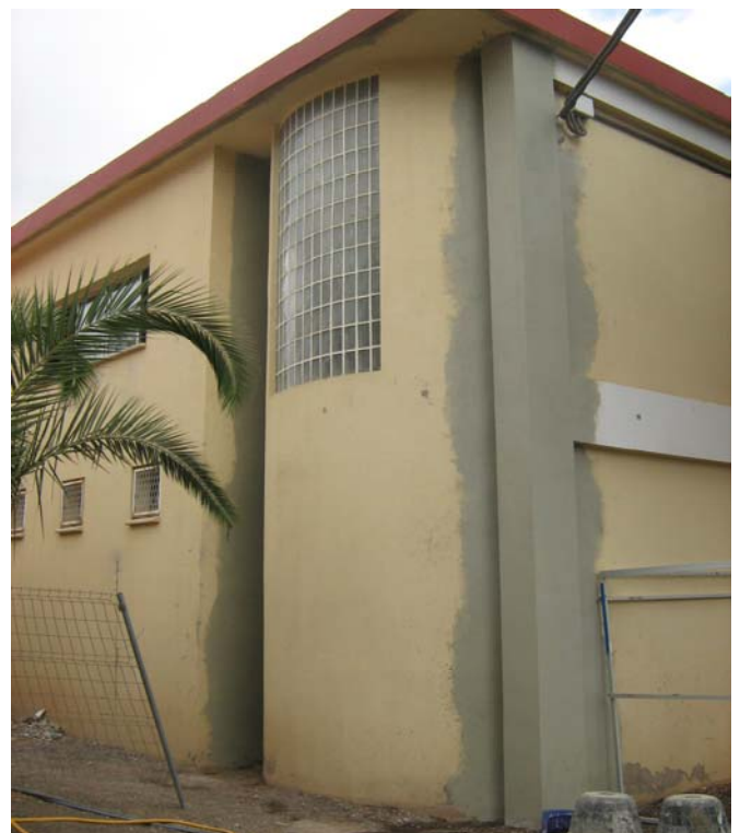
Fig. 16. Revestimiento elástico e impermeable de pilares.
