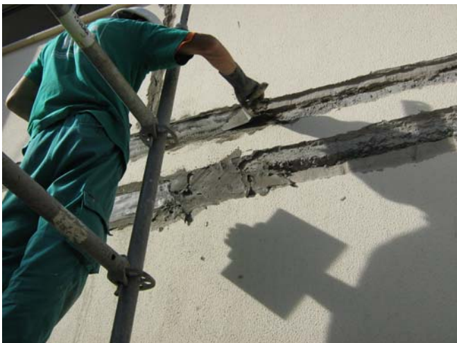
Fig. 18. Reparación de grietas en tabiquería.
