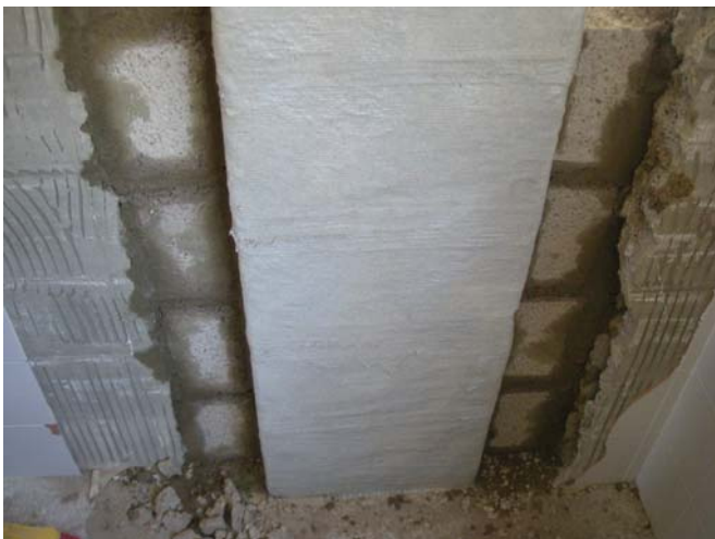
Fig. 14. Cerramiento con bloques de pilar reforzado.
