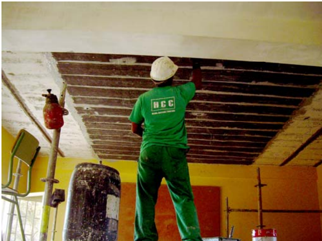
Fig. 21. Estabilización de bovedillas.
