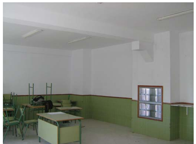
Fig. 20. Cerramiento con escayola de cartela metálica.
