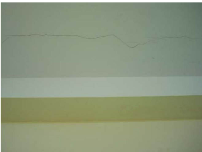
Fig. 4. Fisura longitudinal en el forjado de primera planta.
