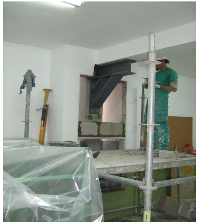
Fig. 19. Refuerzo de viga con cartela metálica.
