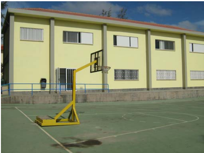
Fig. 25. Exterior del módulo 6 reforzado y pintado..
