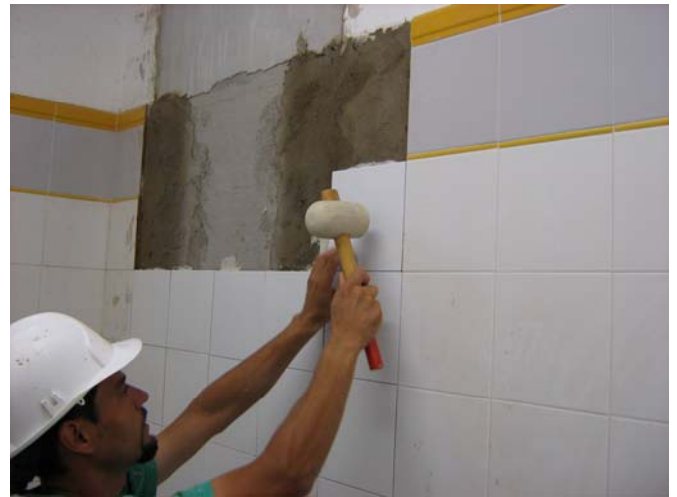
Fig. 15. Alicatado del paramento interior vertical con azulejo.
