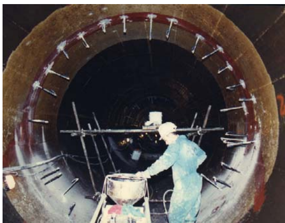
Sellado de juntas en la conducción forzada de Soutelo (Ourense. IBERDROLA). Las juntas soportan presiones internas de hasta 15 bar y externas de hasta 10 bar.
