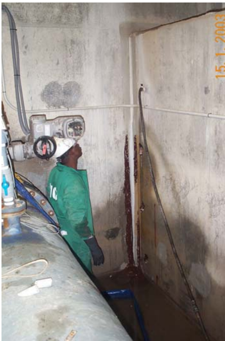
Inyección de sellado de un depósito desde el exterior, en Oceanográfico de la Ciudad de las Artes y las Ciencias de Valencia.
