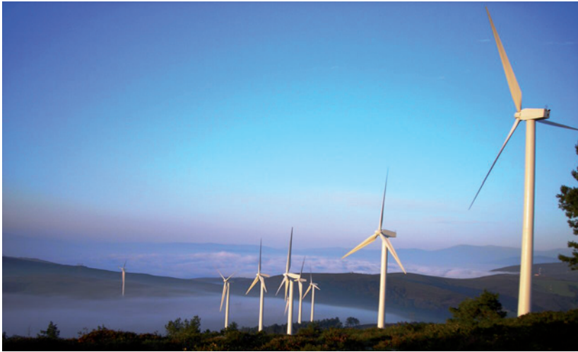
Parque eólico. Cimentaciones reparadas por HCC
